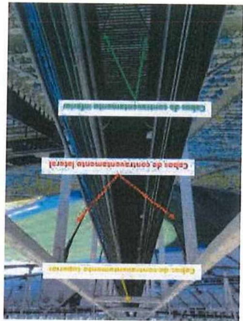
Figura 46 - Localização dos tipos de cabos de contraventamento
