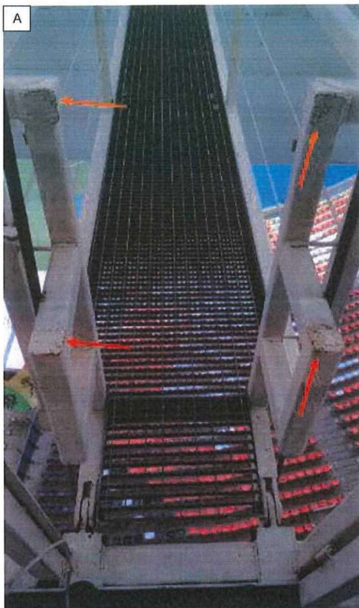
Figura 84 - (A) Oxidação do guarda-corpo da passarela causada, provavelmente, por contaminação e má preparação do substrato durante o processo de pintura do eixo 24,5; (B) danos no revestimento e oxidação de áreas expostas na passarela do eixo 54,5
