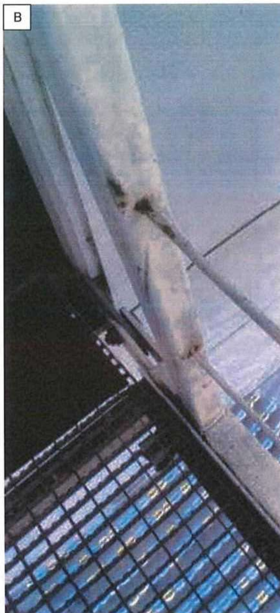
Figura 84 - (A) Oxidação do guarda-corpo da passarela causada, provavelmente, por contaminação e má preparação do substrato durante o processo de pintura do eixo 24,5; (B) danos no revestimento e oxidação de áreas expostas na passarela do eixo 54,5
