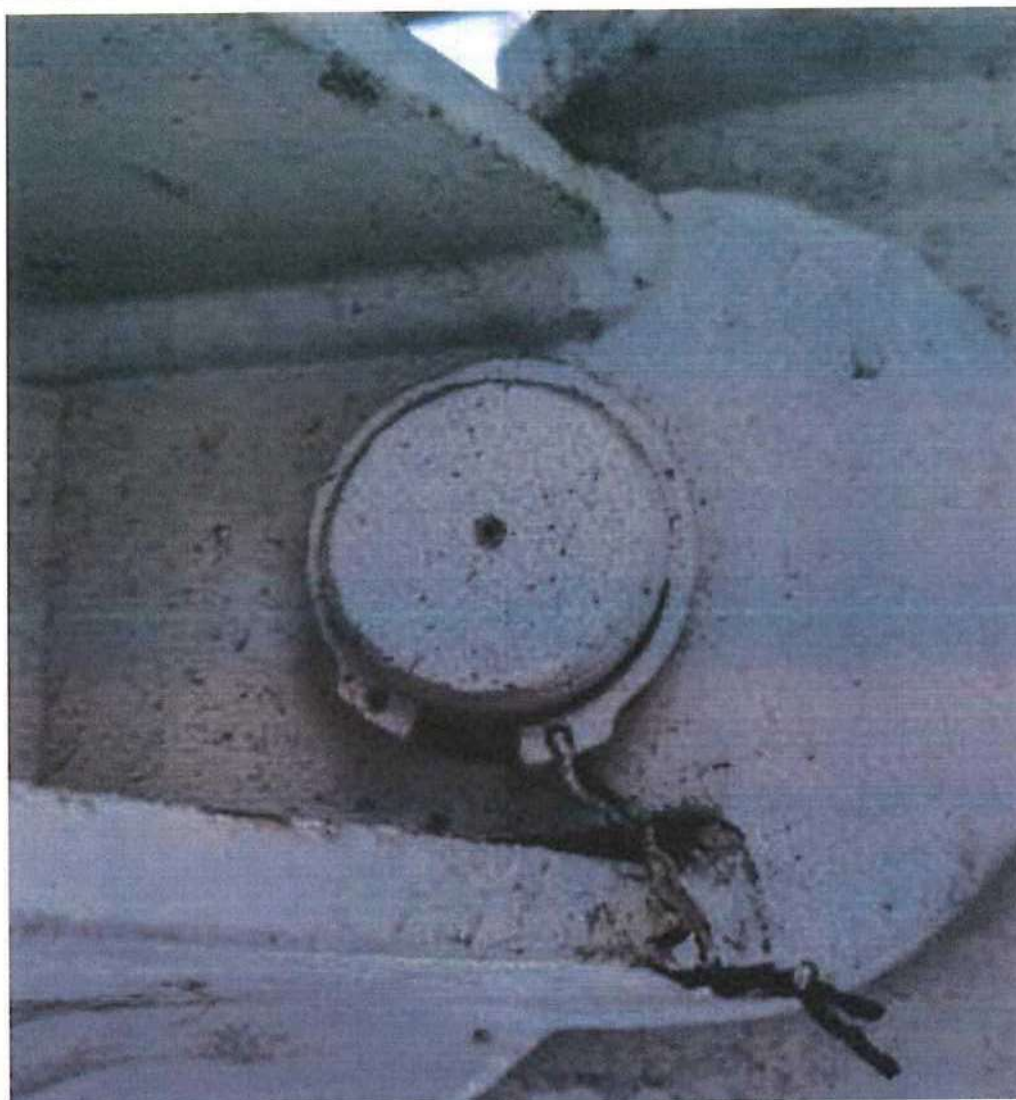
Figura 36 – Anilha de travamento do pino da ligação do mastro com a passarela tangencial do eixo 26 apresentando folga
