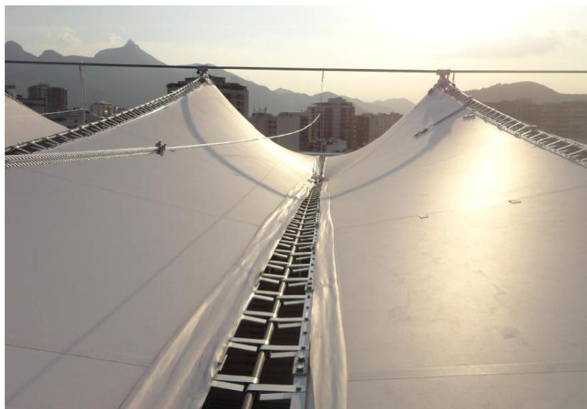
O cabo de sucção é puxado para baixo até o cabo do anel inferior por amarradores criando, portanto, um ponto baixo, onde a água da área frontal é coletada. A água que cai nas áreas
